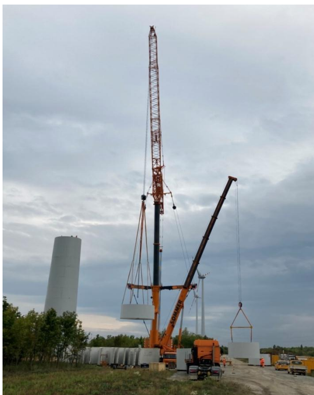
Obr. č. 4 Príklad výstavby vetranej elektrárne s použitím žeriavu
